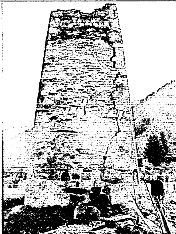
Вид с северо-запада
