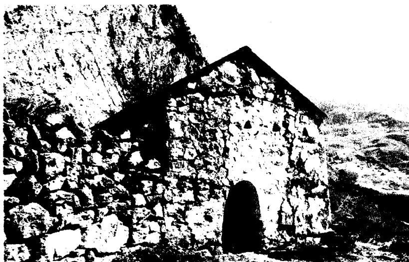
Вид с северо-запада
