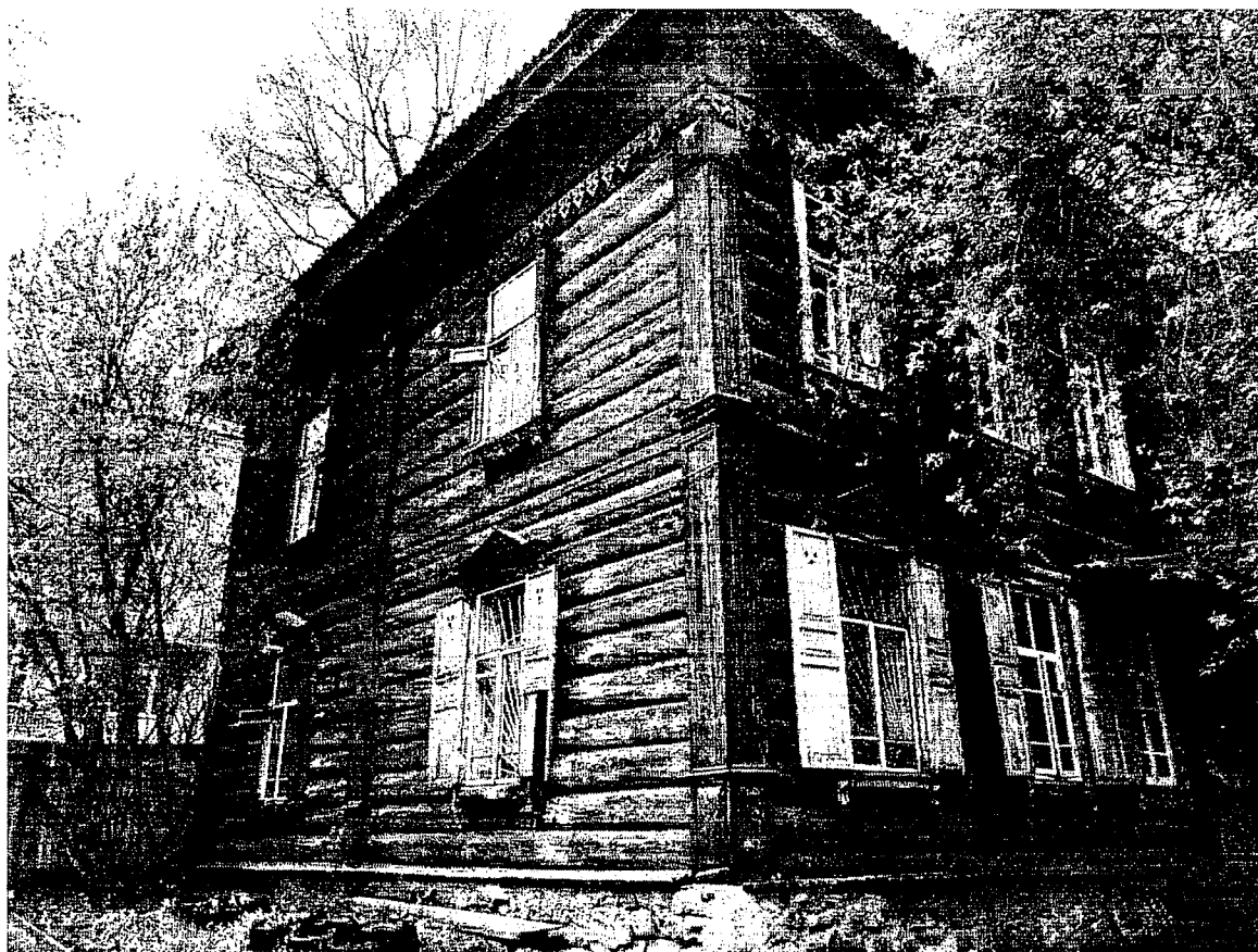
5. Вид на здание с северо-востока.
