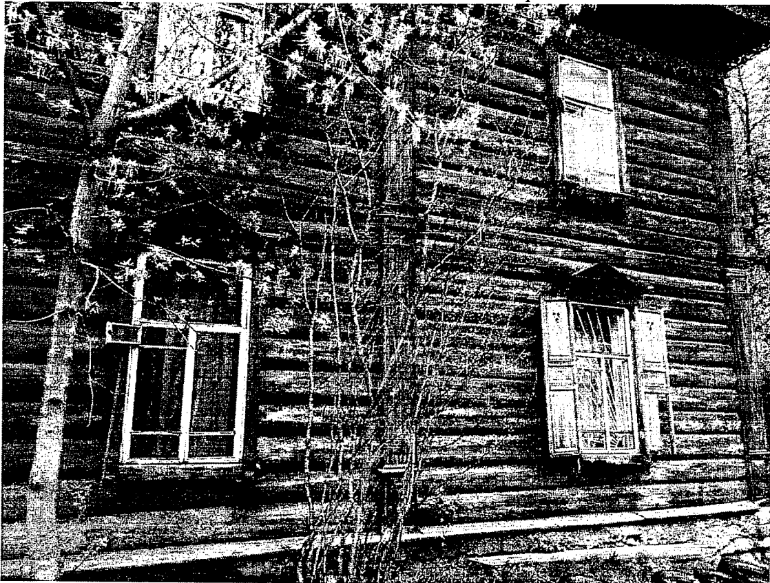
4. Фрагмент бокового юго-восточного фасада.
