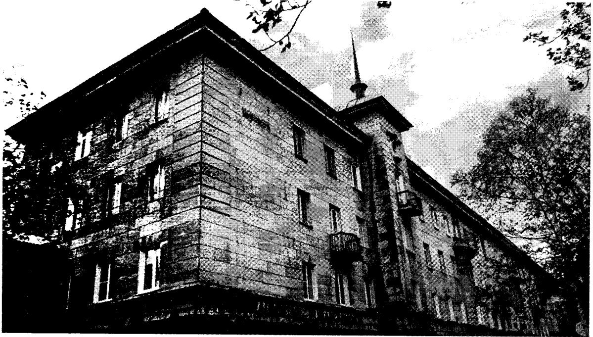
Фото 1. Общий вид здания с проспекта Metallургов. Восточный и северный фасады
