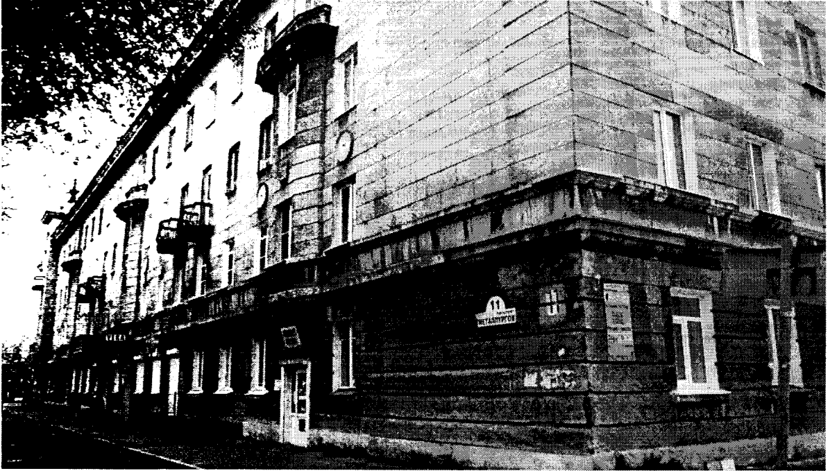
Фото 3. Северный фасад и фрагмент западного фасада
