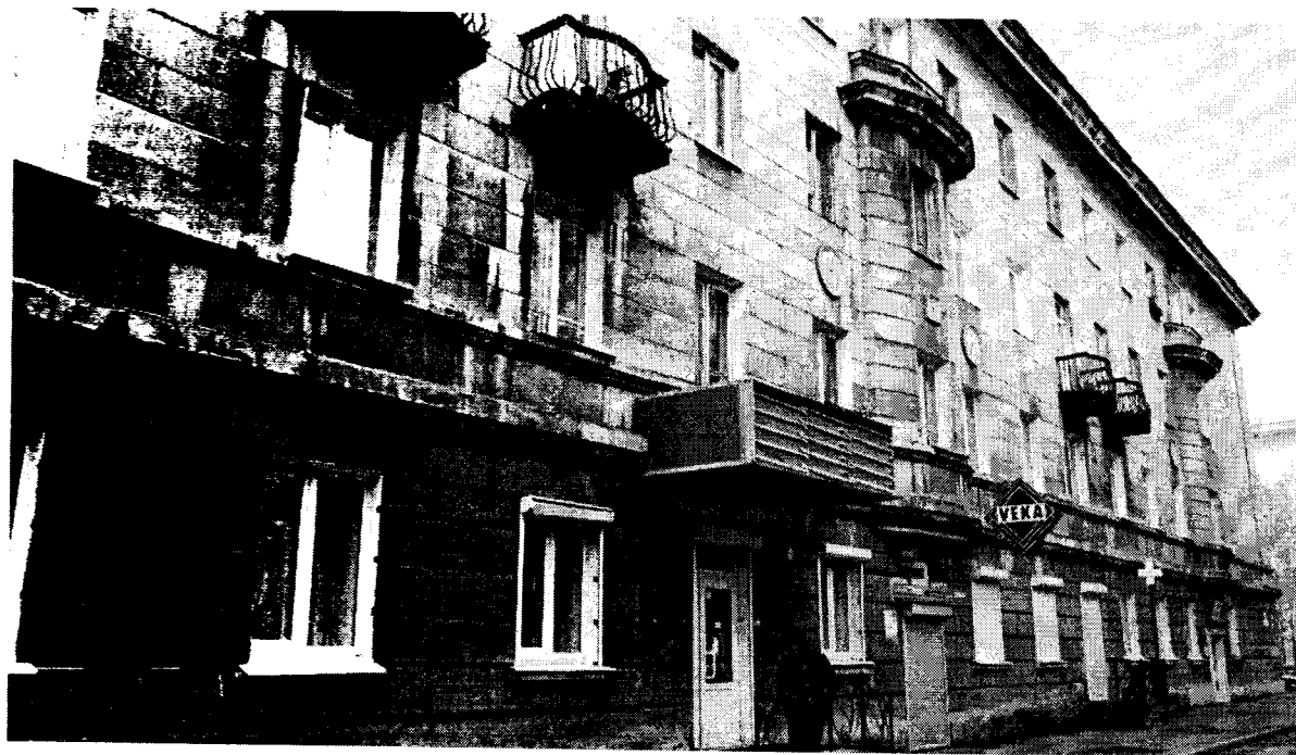
Фото 5. Фрагмент северного фасада
