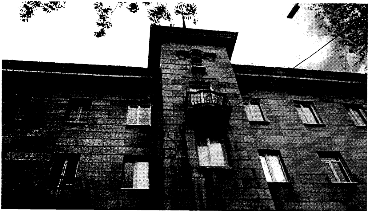
Фото 2. Фрагмент северного фасада
