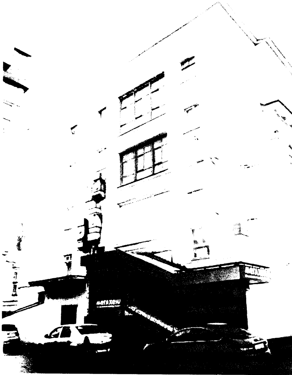
Фото 3. Северо-восточный фасад. Общий вид
