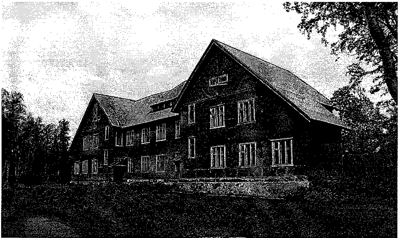
Фото 1. Юго-западный фасад главного лабораторного корпуса
