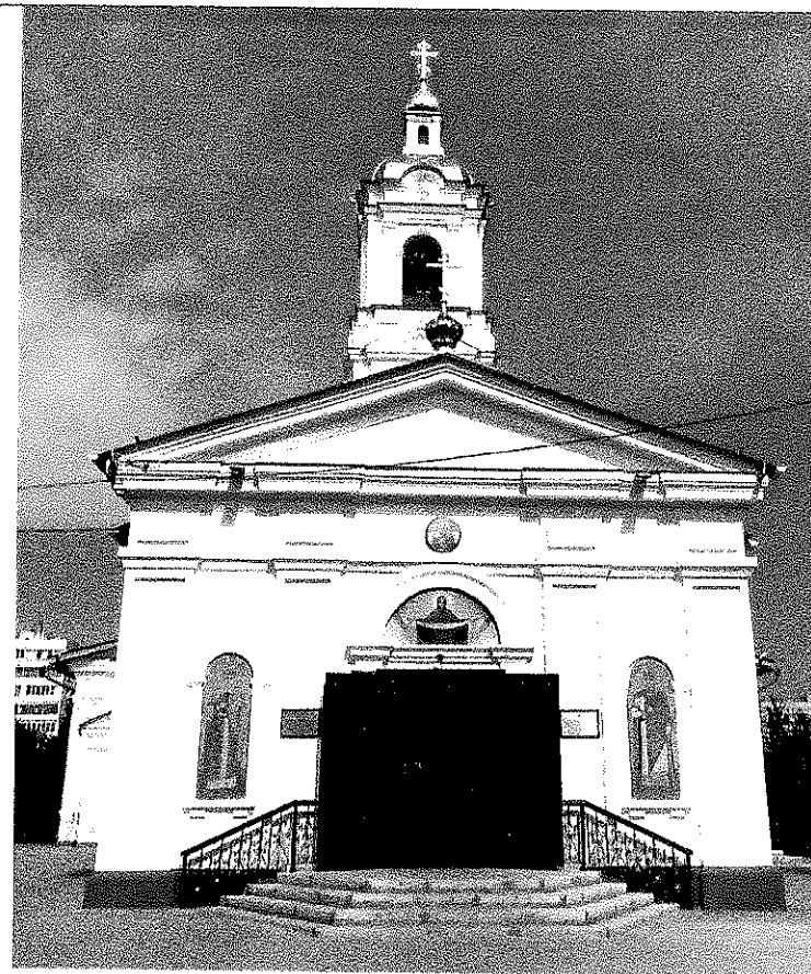
Вид с юго-запада
