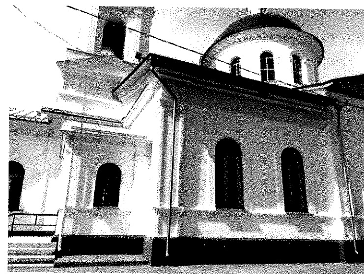
Фрагмент фасада. Вид с юга
