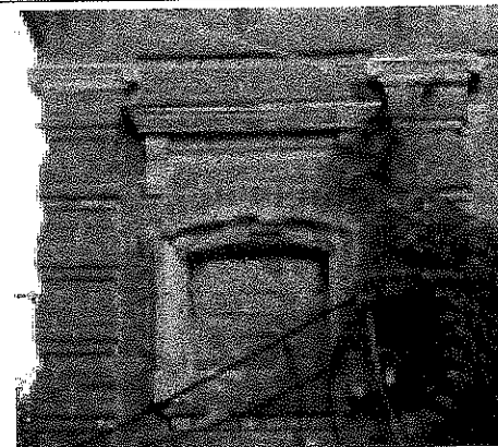
Обрамление оконных проемов.
