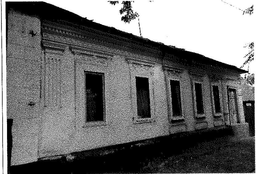
Вид с северо-запада.
