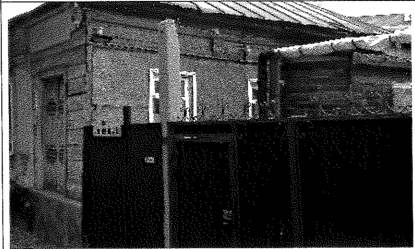
Вид на южный фасад.
