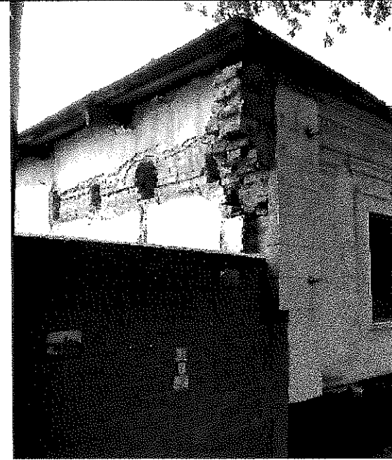
Вид на северный фасад.
