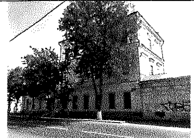
Вид с северо-запада
