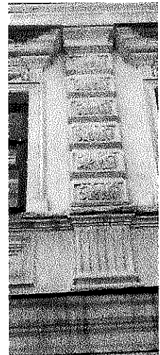
Пилястры второго этажа
