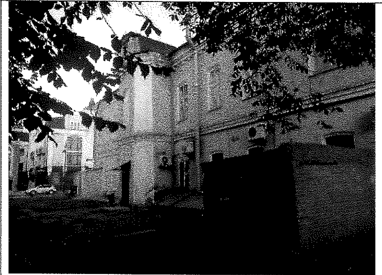
Композиция дворового фасада
