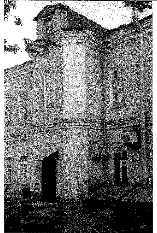
Центральный ризалит дворового фасада
