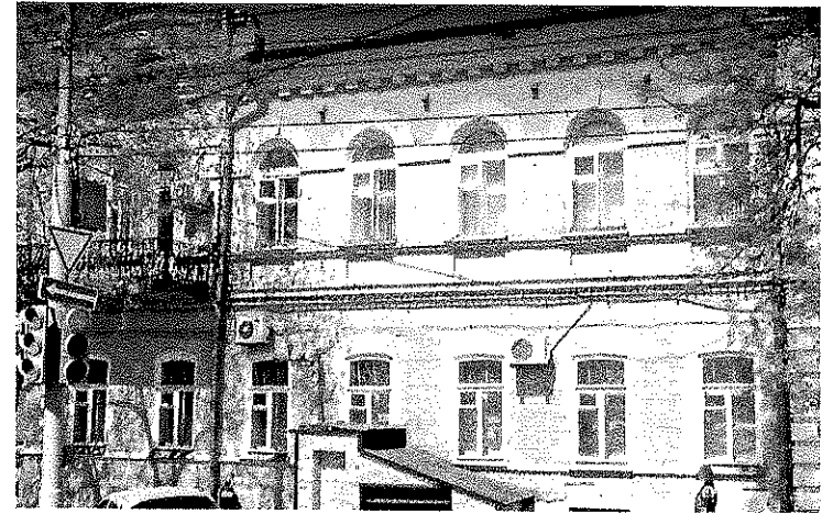
Декор фасада по ул. Пушкинская
