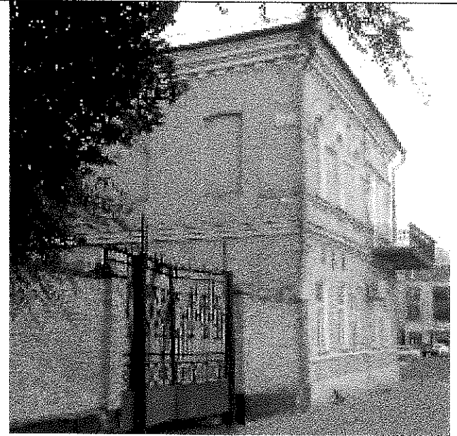
Заложенные оконные проемы
