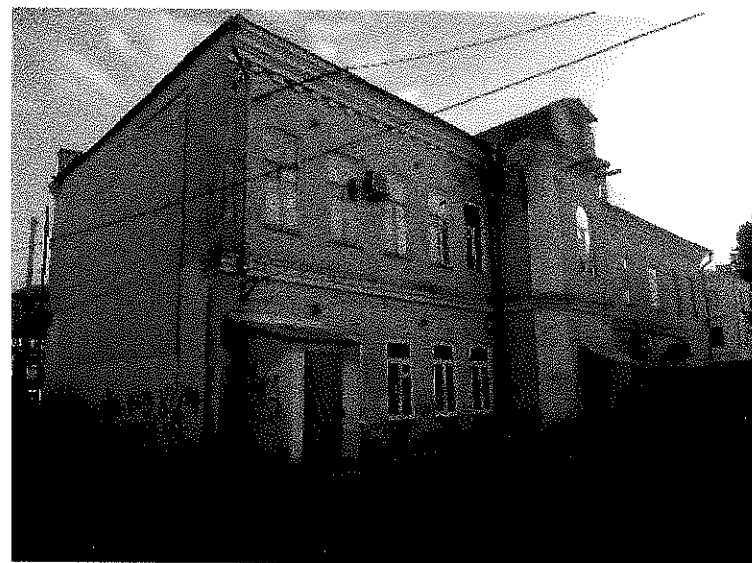
Композиция дворового фасада
