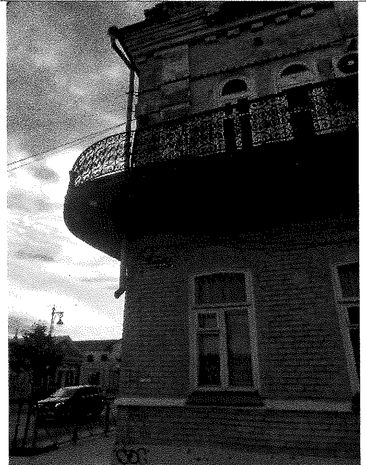
Декор фасада по ул. Пушкинская
