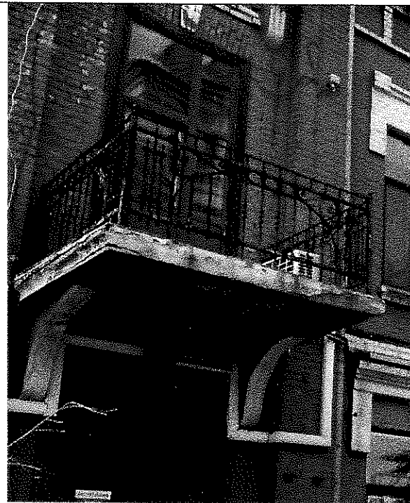
Балконная плита на каннелированных кронштейнах
