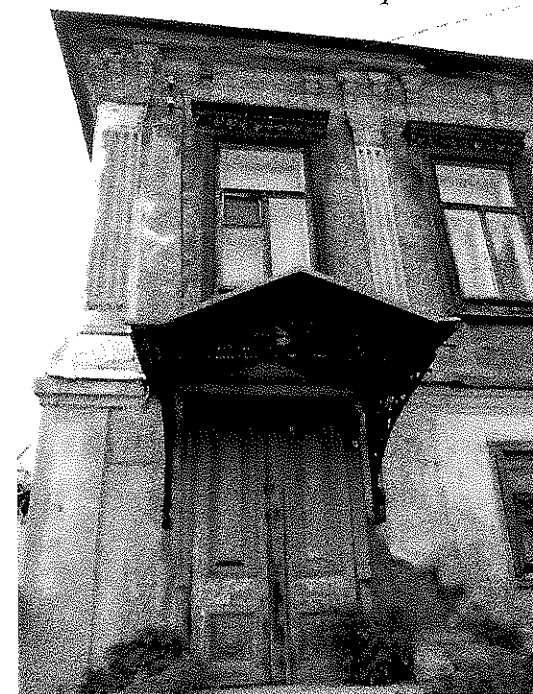
Вид с юга от пер. Гугучкинського. Детали главного фасада. Главный вход
