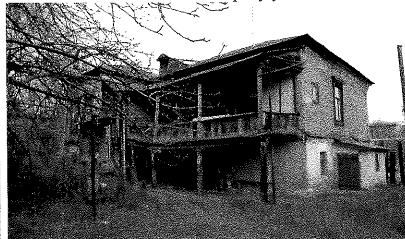
Вид с северо-запада со двора
