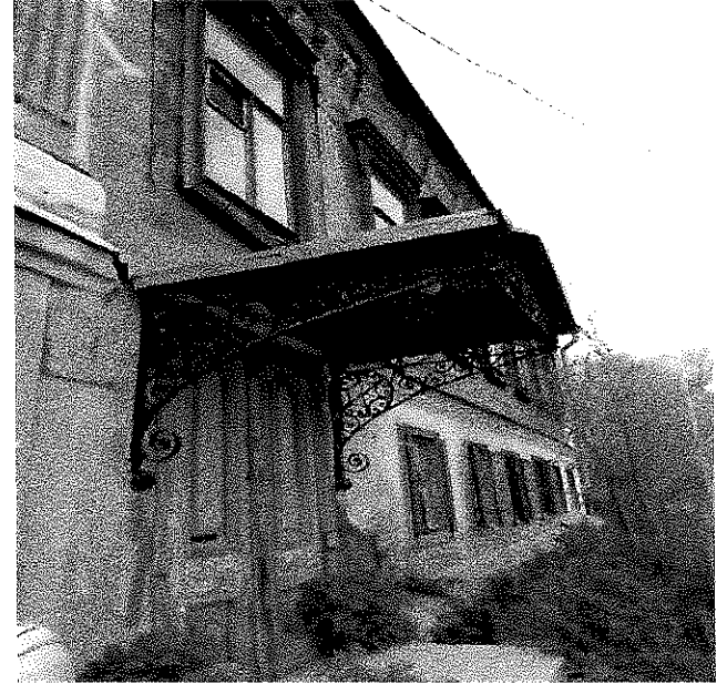
Вид с юго-запада от пер. Гугучкинського. Детали главного фасада. Главный вход
