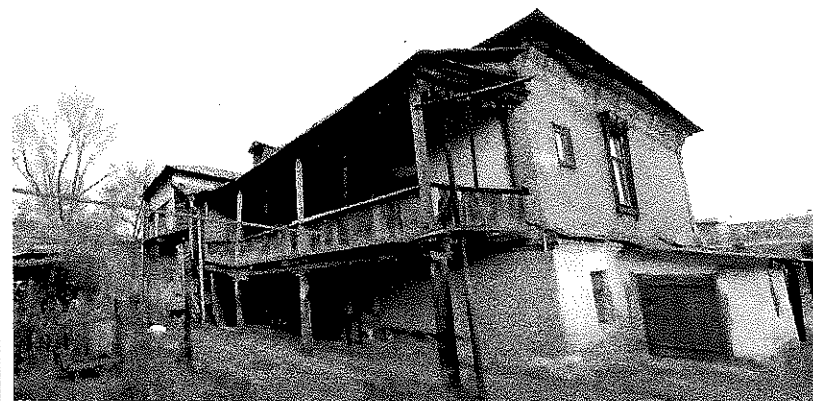
Вид с северо-запада со двора
