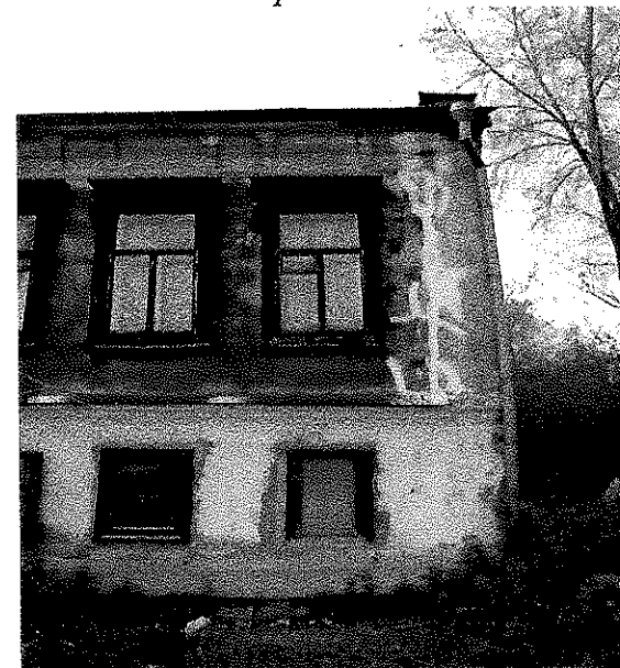
Вид с юга от пер. Гугучкинського. Детали главного фасада
