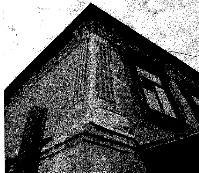
Вид с юго-запада от пер. Гугучкинського. Детали главного фасада
