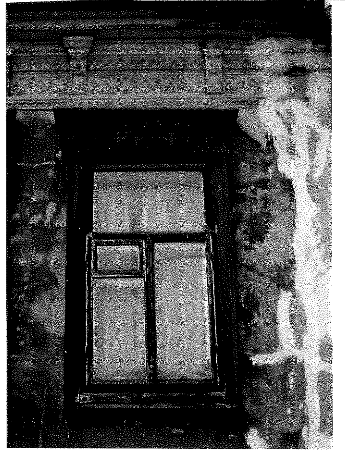
Вид с юга от пер. Гугучкинського. Детали главного фасада
