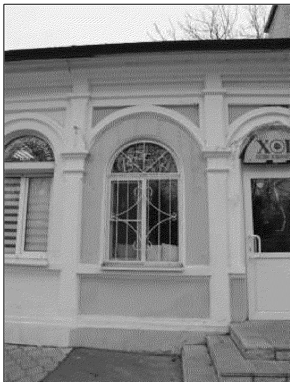
фрагмент главного юго-восточного фасада объекта культурного наследия (арочный оконный проем, промежуточные пилястры)
