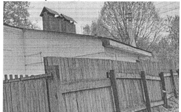
Объём котельной лит. А3
