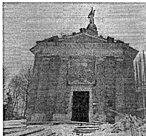
Общий вид западного фасада «Церкви Спаса Нерукотворного Образа»
